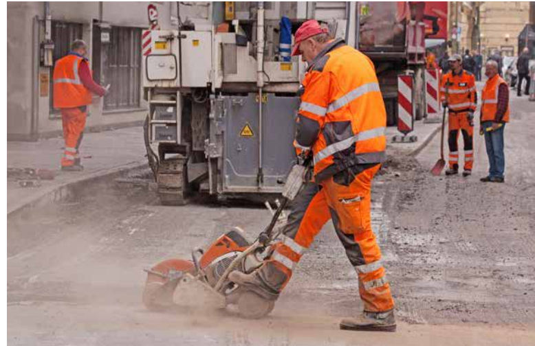
Belagsarbeiten bei St. Gallen.
