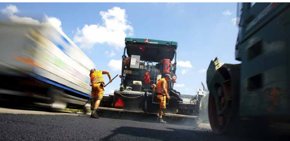
Ein Grossteil der Treibhaus-Emissionen entsteht im Zusammenhang mit Baustellen.
