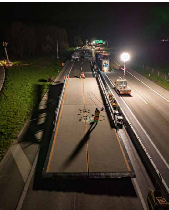
Unter der ASTRA Bridge lassen sich Unterhaltsarbeiten sicher durchführen. Die Brücke kann von einer Baustelle zur nächsten transportiert werden.
