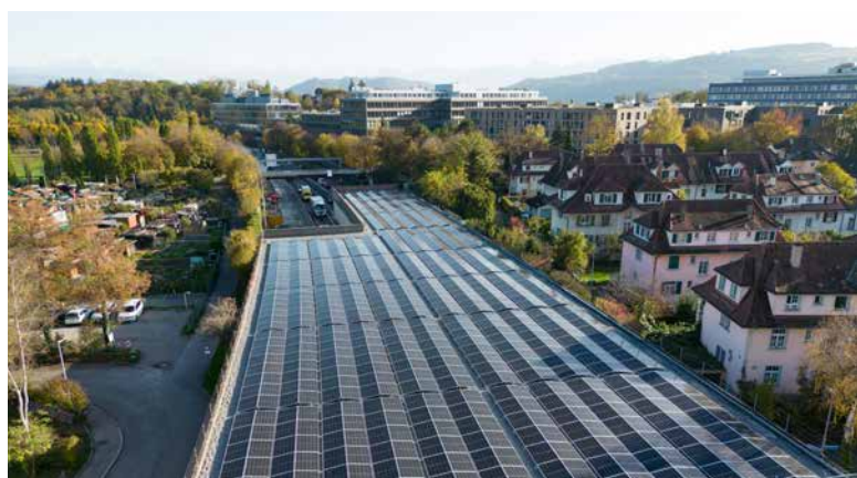
Überdeckung Sonnenhof bei der Nationalstrasse N6 nach Thun
