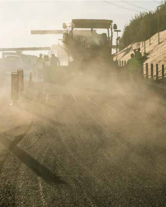
Die Bauunternehmen sind dazu verpflichtet, die Umwelt vor dem Staub zu schützen, der bei Bauarbeiten anfallen kann.
